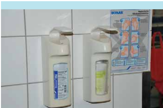
Händedesinfektion ist das A und O. Überall hängen entsprechende Spender mit Anleitung. Das Personal verfügt zudem über kleine Spenderflaschen, die an der Bekleidung befestigt werden können.
